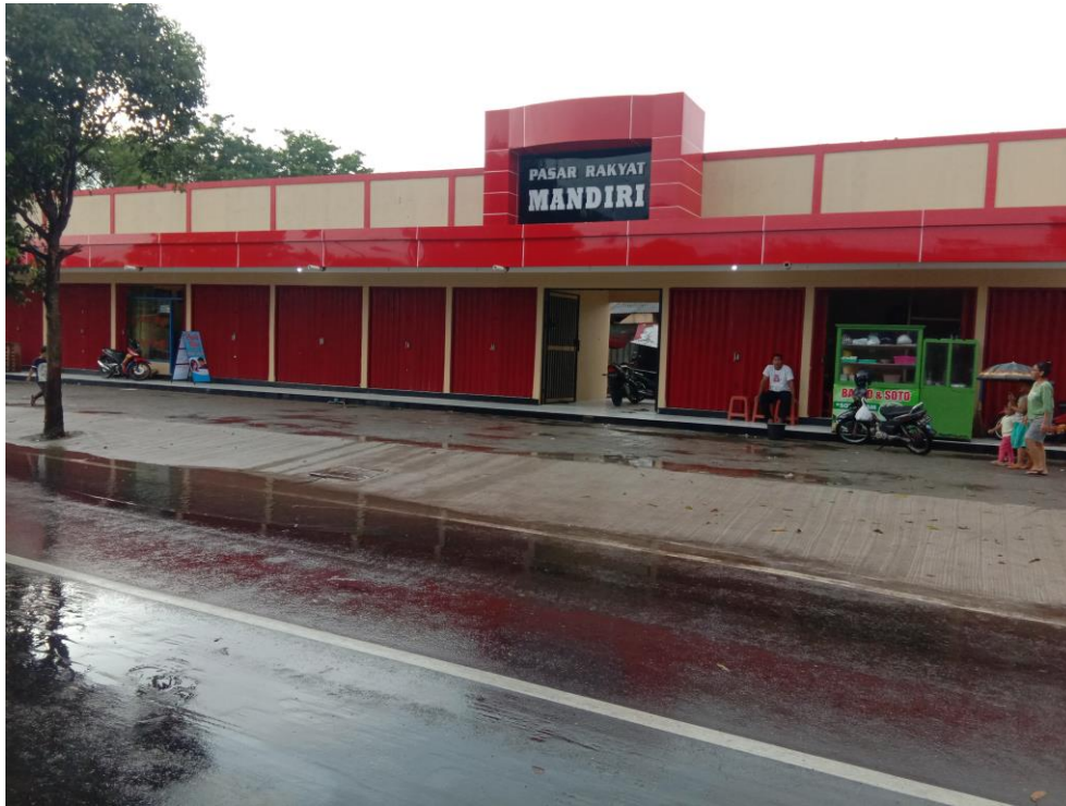
Foto Pembangunan Kios Pasar Mandiri
